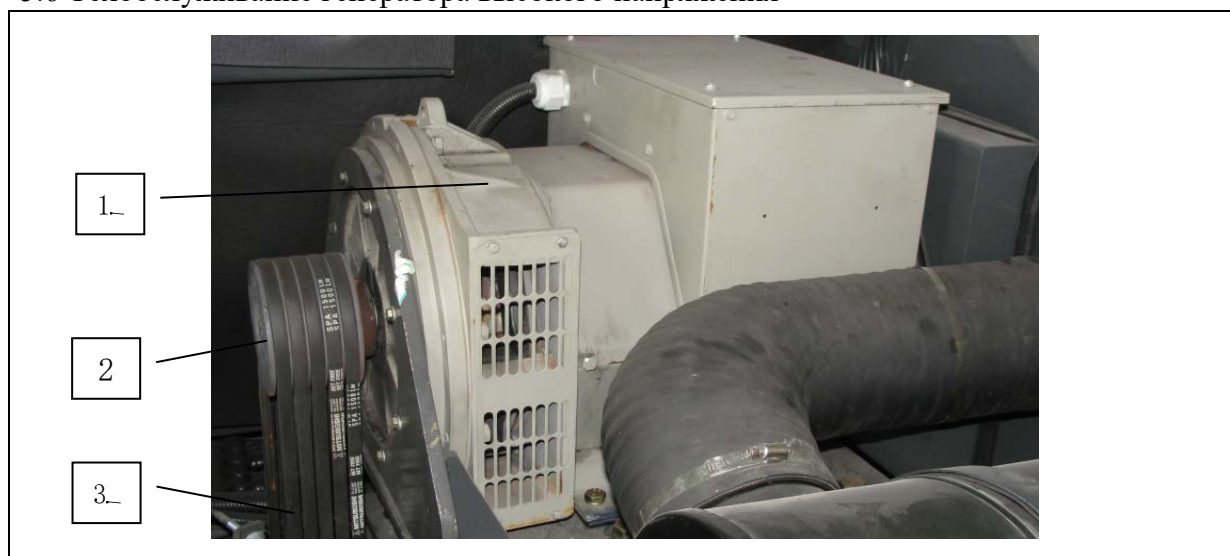
Рис. 5-7. Генератор
