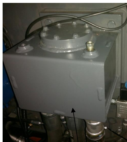
Рис1.2.3.2. Фильтр всасывающий Ф2 Находится под крышкой (на дисплее Ф1)
