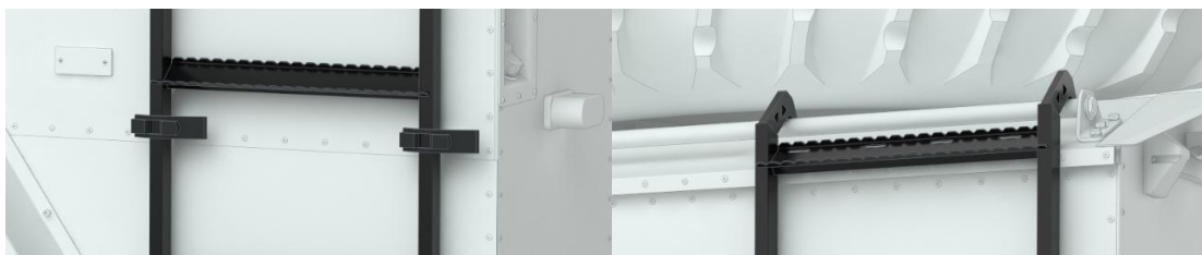
а б Рисунок 8 – Крепления лестницы с наклонными ступенями.
